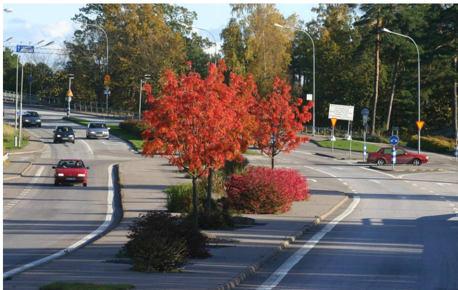
Foto över vägen 2050, rakt fram syns början på Dalbobron, till vänster infartsvägen till Dalbobergen, till höger infart till Blåsut
